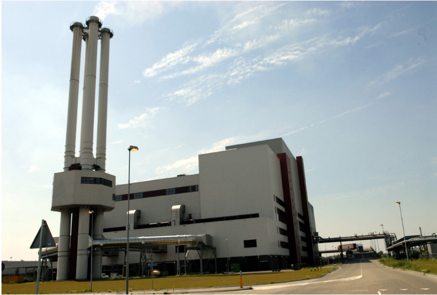
Bild: Attero-Betriebsstätte in Moerdijk
